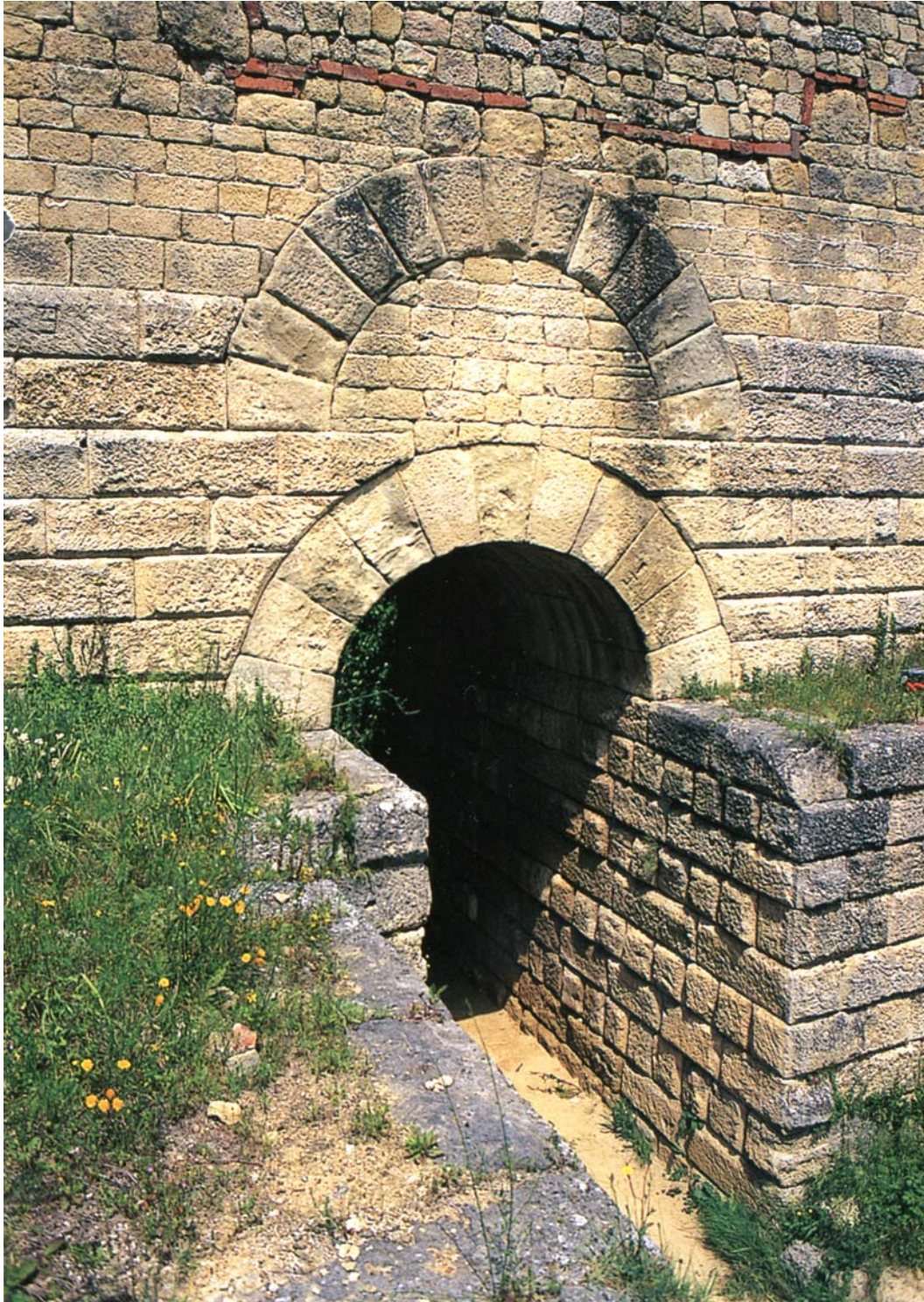
Abb.48: Porta Rosa, Velia Venicanska Bauweise des 4. Jh. v.Chr. Das Gewölbe der Porta Rosa in Velia von einem Entlastungsbogen überfangen um Druck der Steinmasse von Hauptbogen abzuleiten.
